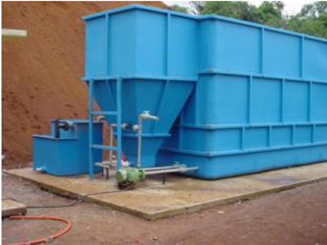
PLANTA CLARIFICADOR PRIMARIO AVANZADO
