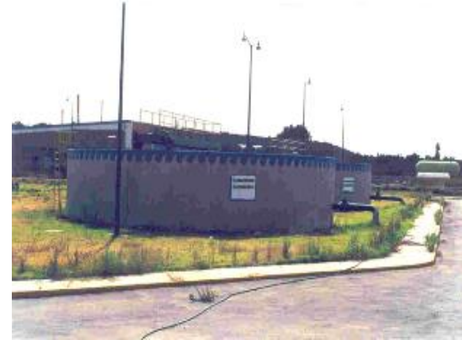
PLANTA AEROBIA DE LODOS ACTIVADOS
