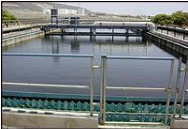
PLANTA DE TANQUE RECTANGULAR POR DIFUSORES
