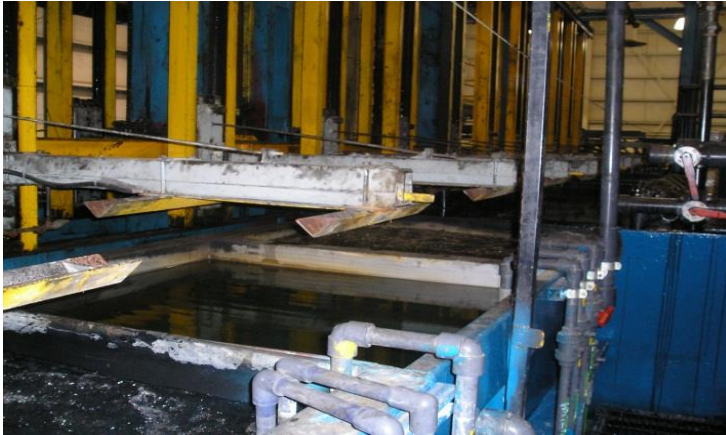
Instalación de Plantas de tratamiento.
