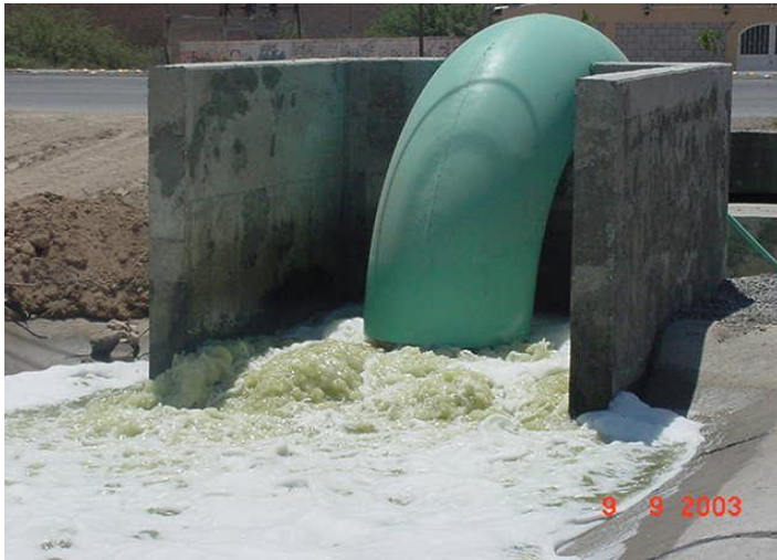
ESTRUCTURA DE DESFOGUE
