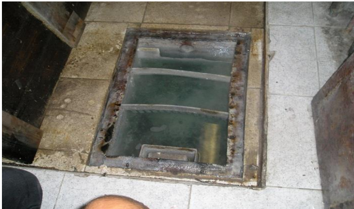
Implementación de trampas para retención de grasas y sólidos.
